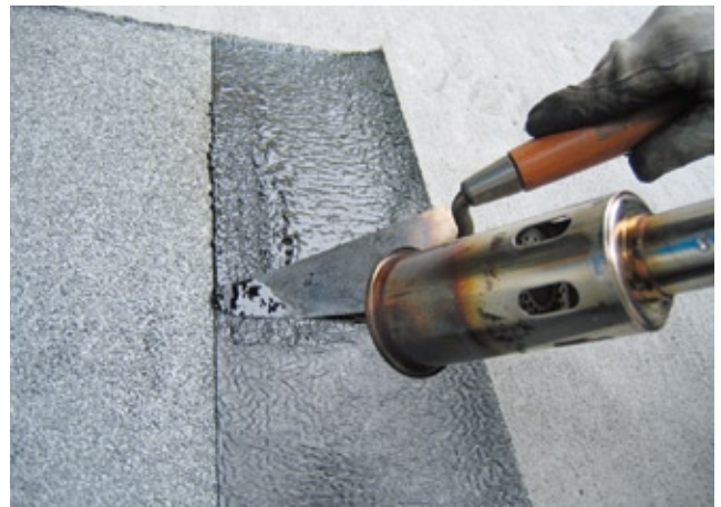
防水シート砂付面の処理
